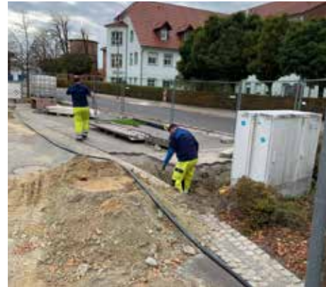
Bauarbeiten auf der Straße des Friedens
