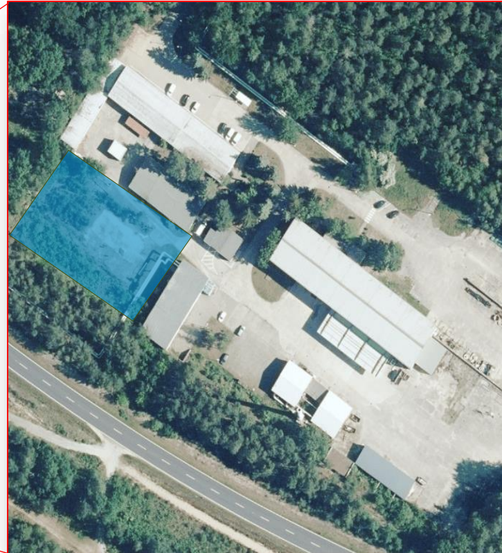
Luftbild: Prof. Wagenfeld-Ring 133, Heizhaus Süd Blau markiert: Bereich Neubau
